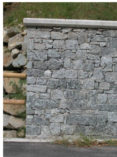
esempio di rivestimento: accettabile
