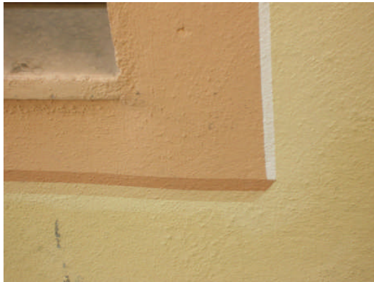
semplificazione della tecnica per simulare elementi in aggetto
