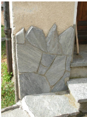
esempi di rivestimento “ a piastrella lapidea” non accettabili
